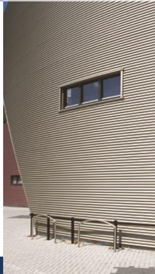
Afrasteringen en hoge stoepranden beschermen de gevel tegen schade door aanrijden.
