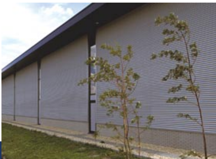
Een grindbed kan het opspreiden van regenwater en vuil tegen de gevel voorkomen.
