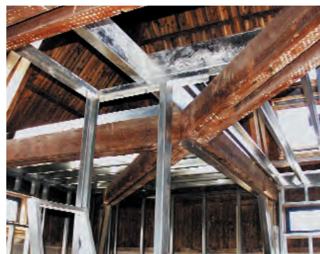
13 De gehandhaafde kapconstructie gecombineerd met in het werk samengestelde dragende staalframebouwelementen (foto: MAT Afbouw, Zaltbommel)
