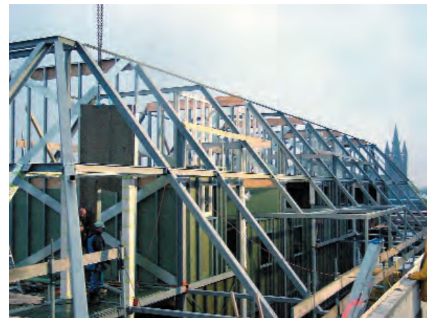
20 Gebouw van Civiele techniek. Diverse aansluitingen van het staalframesysteem aan de warmgewalste tweede draagconstructie (foto's: MAT Afbouw, Zaltbommel).
