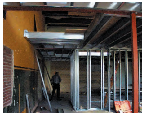
17 Ter plaatse opgebouwde staalframebouwelementen met een hulpconstructie van warmgewalste stalen kokerprofielen
