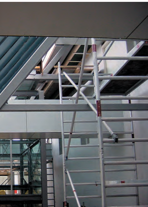
11 Gebouw van Civiele Techniek. Beglaasde kapconstructie in staalframebouw, die bevestigd is aan de tweede draagconstructie. De tussenruimtes zijn ingevuld met staalframe (foto: ABB Ontwikkeling, Sliedrecht).
