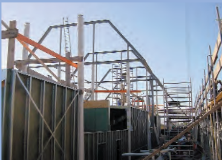
8 Gebouw van Civiele Techniek met staalconstructie en staalframebouwsysteem. Tussen de herbestemde oudbouw en de nieuwbouwwoningen ligt een atrium met glaskap. De wand aan de zijde van de oudbouw (links op foto met stabiliteitskruisen) is uitgevoerd in staalframebouw (foto: ABB Ontwikkeling, Sliedrecht).
