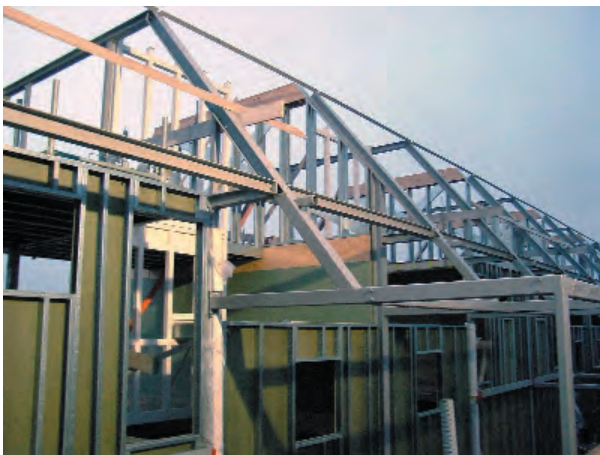
20 Gebouw van Civiele techniek. Diverse aansluitingen van het staalframesysteem aan de warmgewalste tweede draagconstructie (foto's: MAT Afbouw, Zaltbommel).
