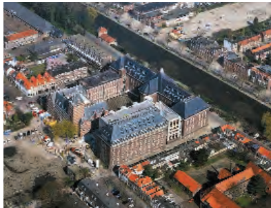
2 Schuttersveld in de nieuwe situatie met op de voorgrond het gebouw van Civiele Techniek, aan de overkant van het binnenterrein het voormalige boekendepot en aan de waterkant de hoofd vleugel van de voormalige bibliotheek (foto: Cede Photoservices, Kamperland).
