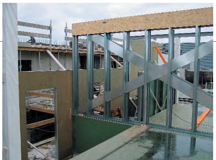
16 Dubbel uitgevoerde woningscheidende wand in staalframebouw. In verband met de windbelasting is de wand voorzien van een stabiliteitskruis (foto: MAT Afbouw, Zaltbommel).
