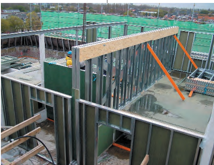
15 Dubbel uitgevoerde woningscheidende wand en (lagere) wand met toegangsdeur, beide in staalframebouw (foto: MAT Afbouw, Zaltbommel).
