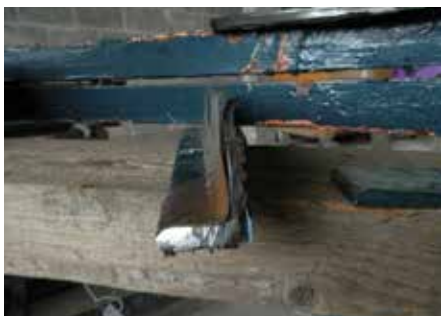
7. Aantasting van binnenuit bij een geklonken profielenpaar (de afbeelding toont de helft van het profielenpaar). Aangetaste spanten waar in het verleden ter versterking al strippen opgelast zijn
