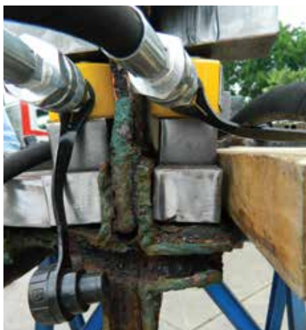
11. Met vijzels wordt geprobeerd de vorkverbinding tussen spant en langsliggers te lossen. Door de hoge mate van materiaal aantasting is dat bij dit spant niet meer mogelijk.
