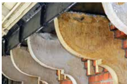
9. Natuurstenen console onder gootconstructie.
