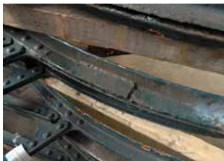
7. Aantasting van binnenuit bij een geklonken profielenpaar (de afbeelding toont de helft van het profielenpaar). Aangetaste spanten waar in het verleden ter versterking al strippen opgelast zijn
