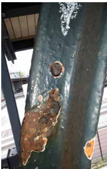
6. Aantasting van spant bij de overgang naar gietijzeren kolom.
