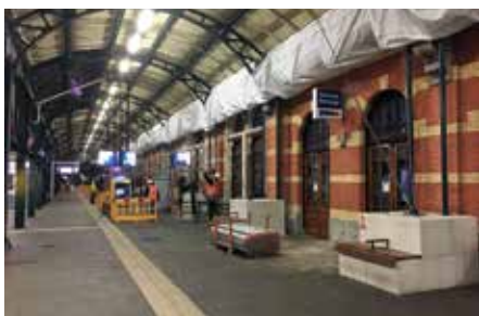
8. Tijdelijke tuidraden en stempels om consoles te fixeren. Netten tegen vallende delen.
