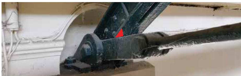
22. Mechanisme met een kleine las fixeren (rood, iets vergroot).
