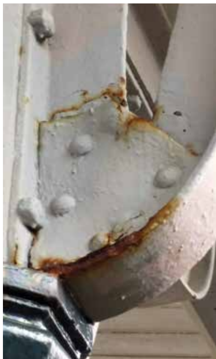
15. Corrosie in een verbinding die een 'open bakje' vormt voor regenwater.
