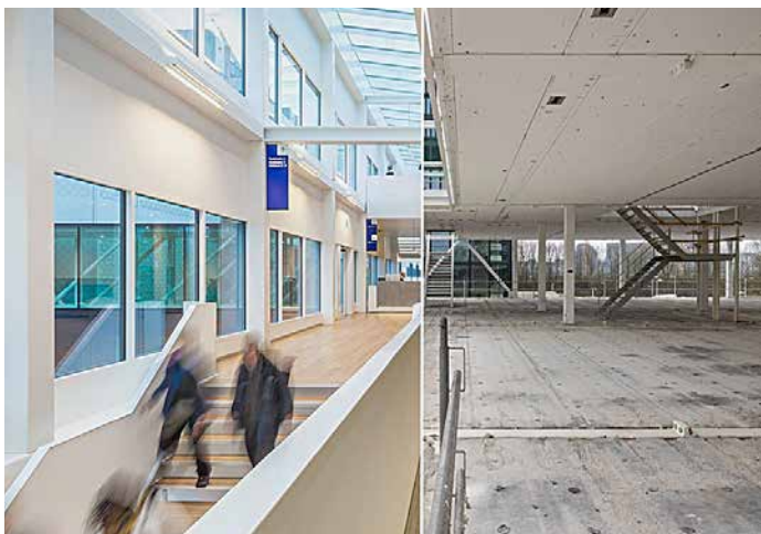
Demontage Tijdelijke Rechtbank Amsterdam (Lucas van der Wee).
