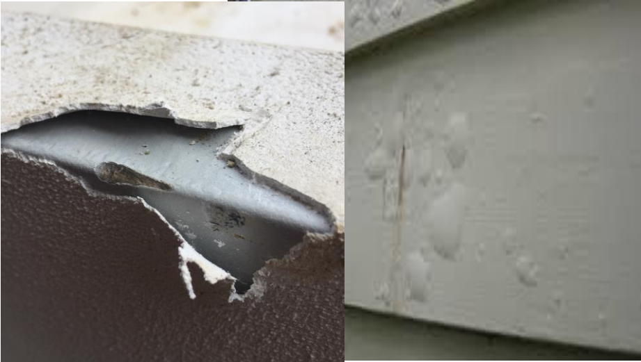
Solventinsluiting na te snelle overlaging
