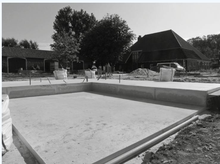
Testopstelling van Trilling Absorberend Schuimbeton (TAS).
