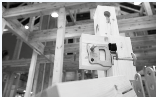
Het SUTEKI Wood System wordt gekoppeld door middel van koolstofstalen koppelingen.
