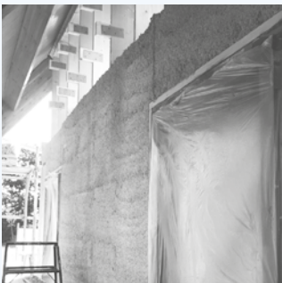
Kalkhennepwand in aanbouw.
