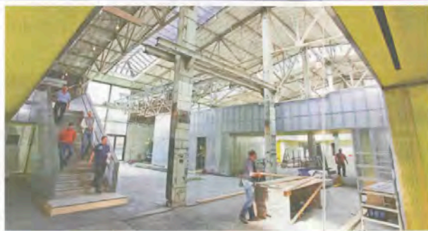
De nieuwe kantoren dragen de krachten via een speciale overloopvloer af op de bestaande draagstructuur. Sommige delen zijn opgehangen aan de kolommen van de kraanbaan.
