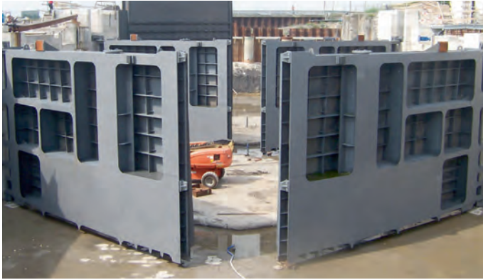
5. Puntdeuren Kattendijksluis Antwerpen (B).
