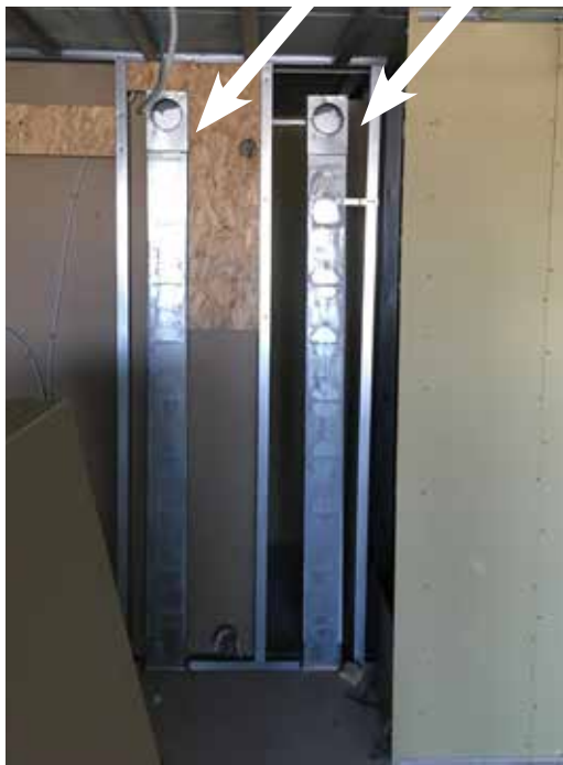
ventilatie in wanden uit de vloer
