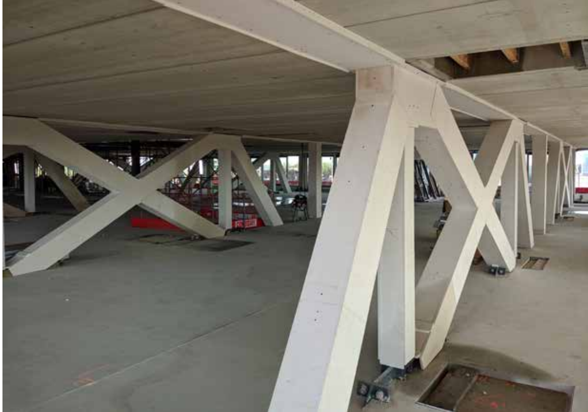
het casco brandwerend bekleed
