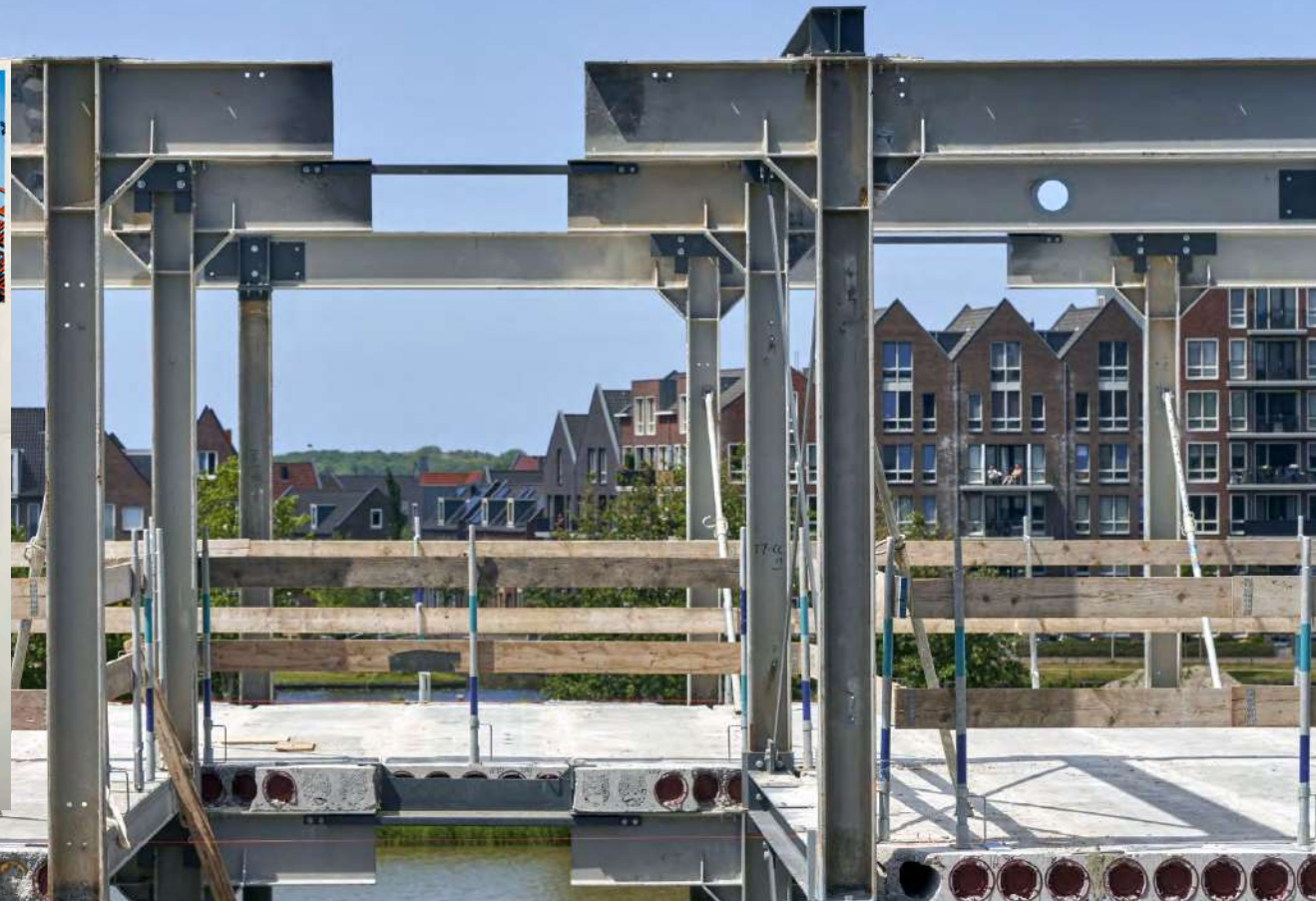
NTA 8713 • hergebruik stalen constructie-elementen
