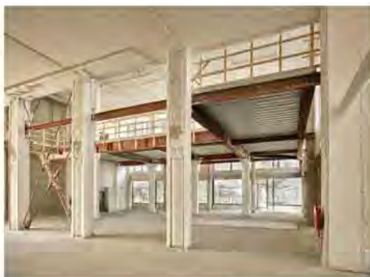
5. De renovatie van Hoogstraat 168-172 in Rotterdam, project met hergebruik van staalprofielen.
