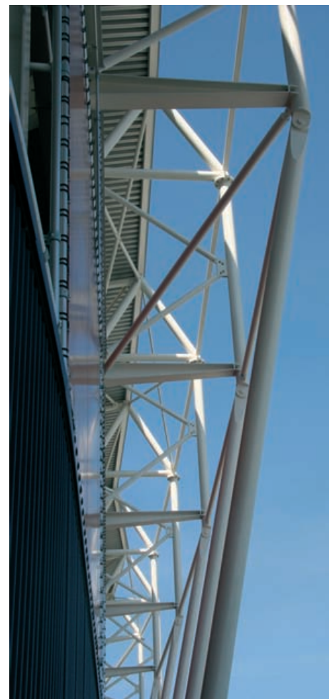
De spanten hebben aan de onderzijde een driehoekige vorm. De diagonaal draagt de tribune.
