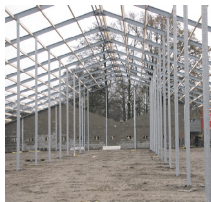
▲▲ Staalconstructie voor pluimveestal.
