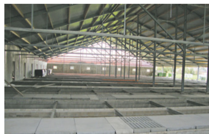
▲ Staalconstructie met vrije overspanning voor varkensstal.
