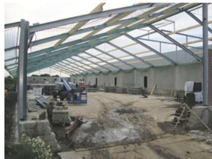
▲ Staalconstructie met tussenkolommen voor varkensstal.
