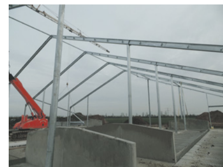
▲ Staalconstructie met tussenkolommen voor rundveestal.
