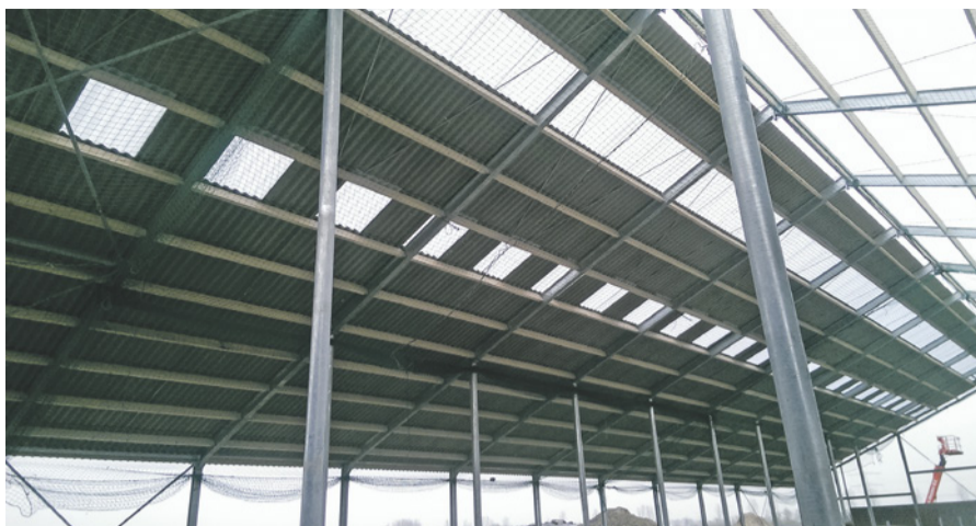
▲ Staalconstructie met vrije overspanning voor rundveestal.
