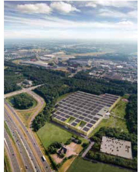
BENG geldt onder andere nog niet voor een industriefunctie, denk aan hallen, bedrijfsgebouwen en distributiecentra als Schenker in Venlo (boven).
