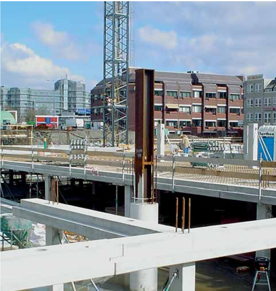
12. Volledig omstorte staal-beton kolom in het werk.
