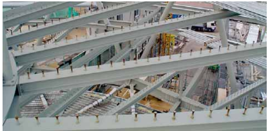
11. Staal-beton ligger in het werk, voor het aanbrengen van de betonvloer.
