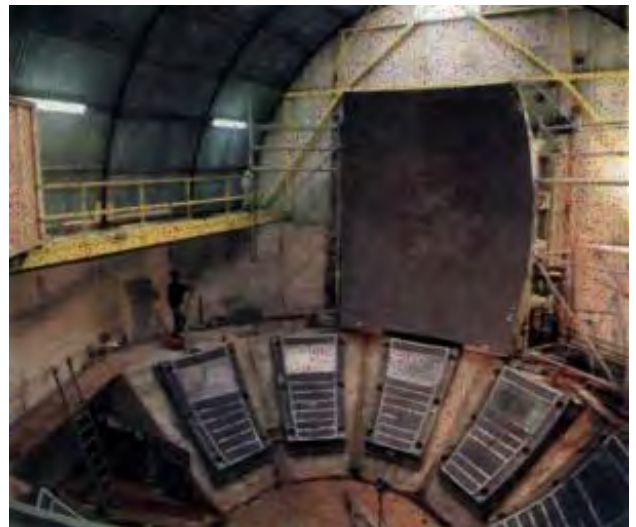
Figuur 50 bolscharnier Maeslantkering
