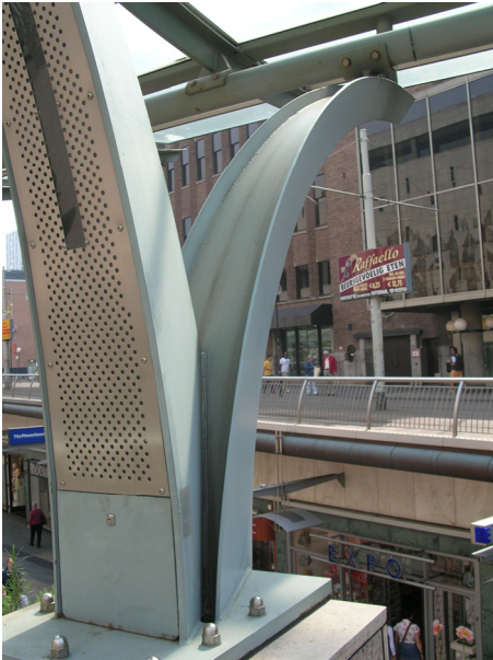
Figuur 4. Deltarib avant la lettre: een gekromde rib met driehoekige doorsnede in de luifel boven de Beurspassage in Rotterdam, maar symmetrisch en niet in een netwerkconstructie.
